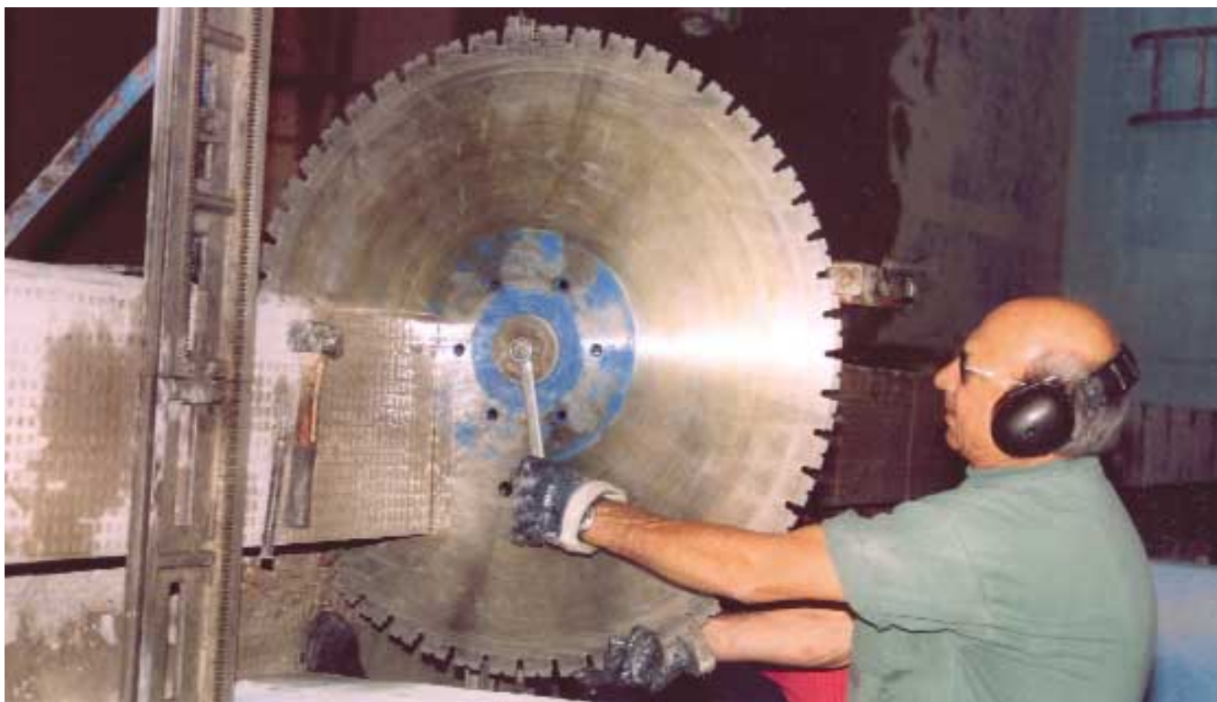
Il disco diamantato, di quasi un metro di diametro, ha appena terminato uno dei numerosi tagli trasversali con i quali sono state suddivise in blocchi le due porzioni longitudinali del bordo piscina, delimitate dai tagli lunghi 25 metri. Visibili, in primo piano, le guide staffate, pronte per l'esecuzione dei tagli successivi
